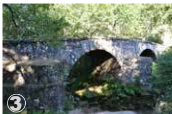
3 "Ponte dos Eixões"
